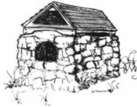
Four avec voûte en briques recouverte d'une maçonnerie en pierres des champs Kamouraska Collection Blanchette, Archives du C.C.E.C.T., cote 194
