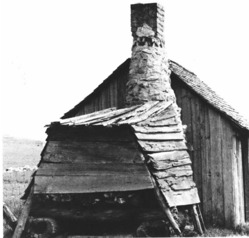
Four semi-intérieur à un bâtiment détaché. Saint-Hilarion (C ité de Charlevoix) Collection Blanchette , M.N.C. nég. n° 73-25993
