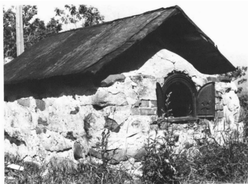
Four avec voûte en briques dont les côtés sont protégés par une maçonnerie de pierres des champs liées par du mortier. Kamouraska Collection Blanchette, M.N.C. nég. n° 74-14626
