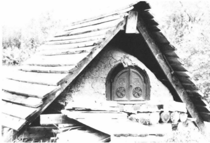
Four en terre avec abri de planches à clan; construit à l'été de 1971 à Saint-Ambroise Il perpétue le souvenir. Lac Saint-Jean Collection Blanchette, M.N.C. nég. n° AC-21-74-2
