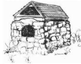
Four dont la voûte est en briques et dont tous les côtés ainsi que la façade sont protégés par une maçonnerie grossière. Région de Kamouraska Collection Blanchette, Archives du C.C.E.C.T., cote 194
